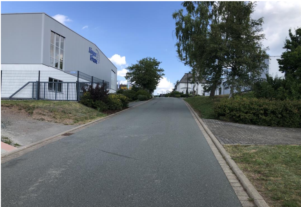
Abb. 6 – Erschließungsstraße 'Beuke' im sehr gutem Erschließungs- und Ausbaustandard
