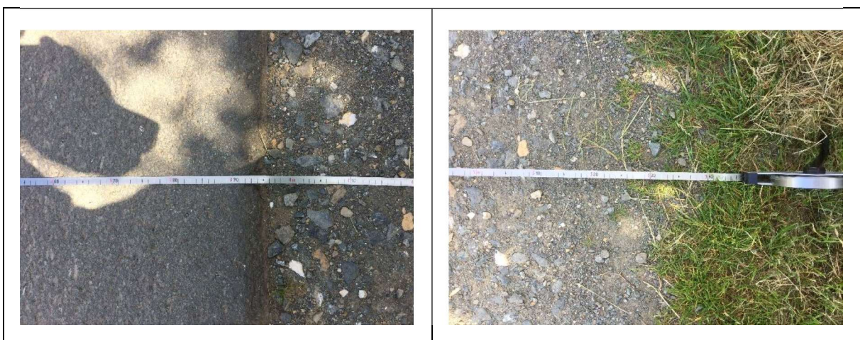
Abbildung 3: Breite der asphaltierten Fläche und der insgesamt nutzbaren Fahrbahnbreite
