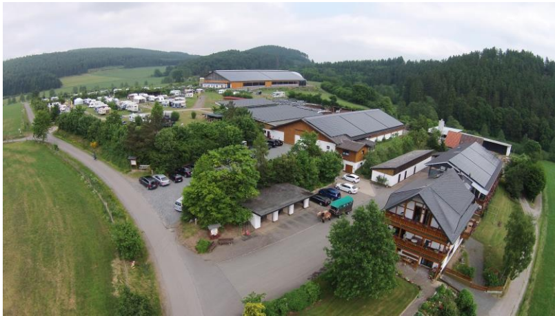
Abb. 6 - Blick auf das Gebiet der 25. Änderung des Flächennutzungsplaners mit dem ,Ferienhof zur Hasenkammer' (hat sich baulich zwischenzeitlich verändert) und dem Campingplatz und einigen (noch) landwirtschaftlich genutzten Gebäuden und Einrichtungen', im Hintergrund Hofstelle ,Schmidt'
